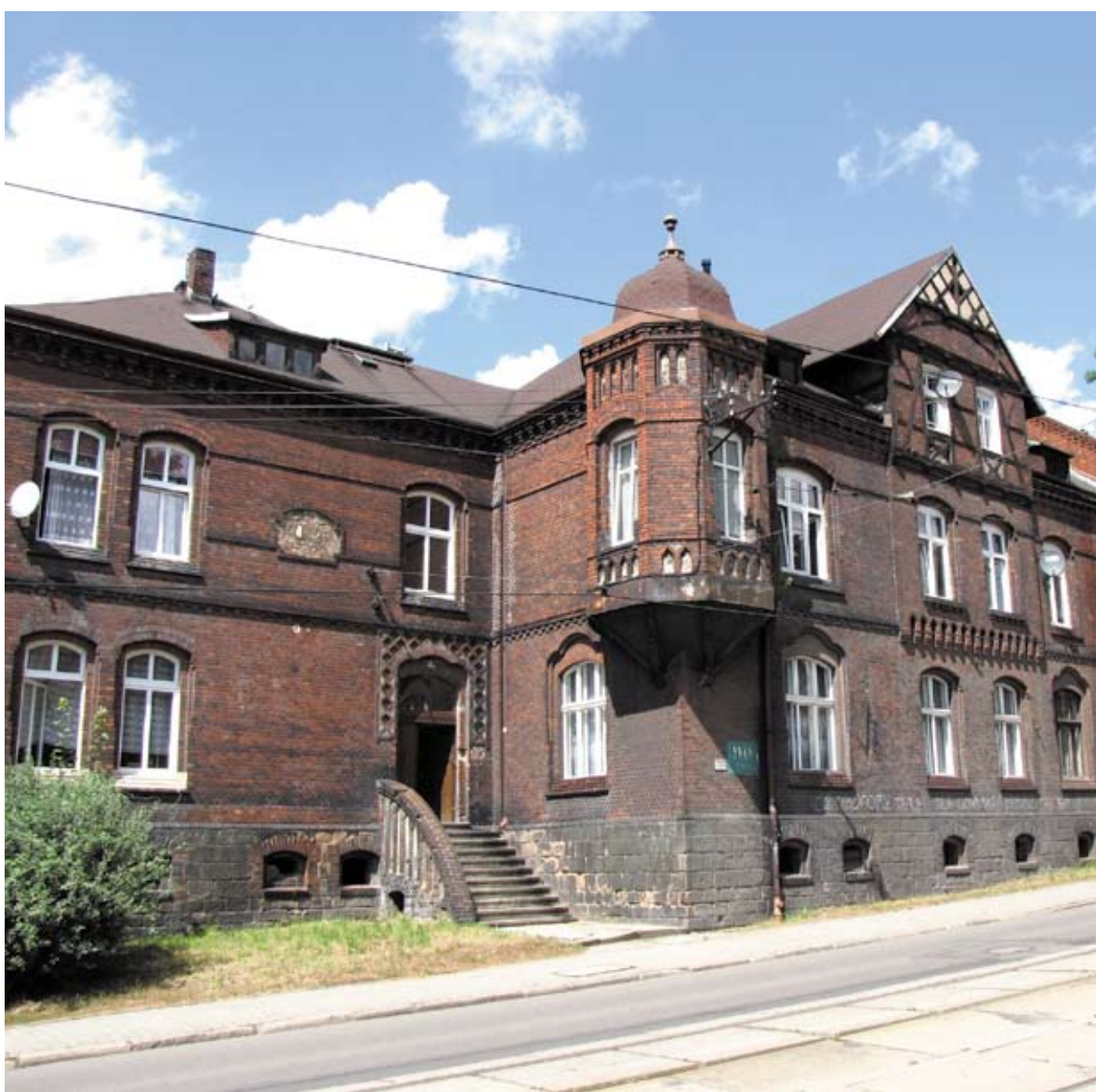
Zabudowa przy ul. Bytomskiej
