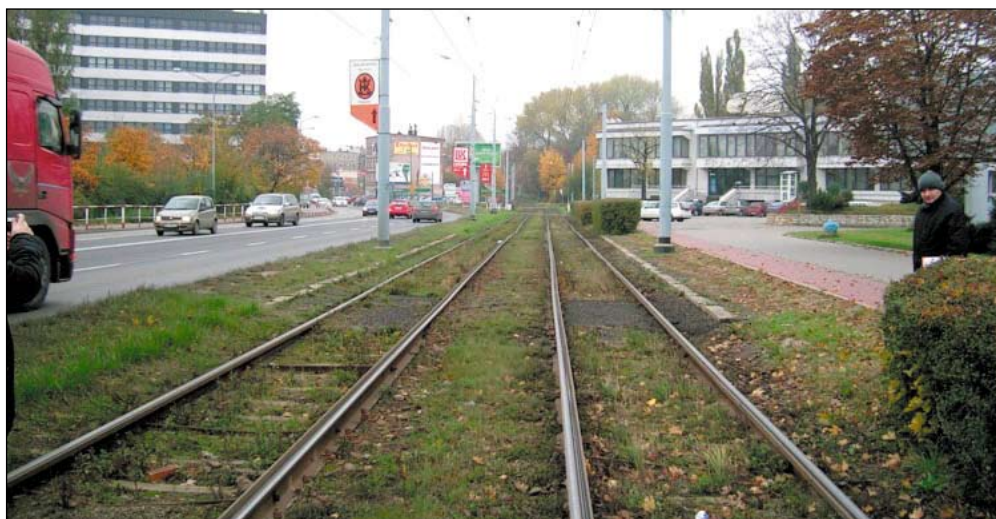
Prace obejmą m.in. torowisko wzdłuż ul. Katowickiej w Chorzowie...
