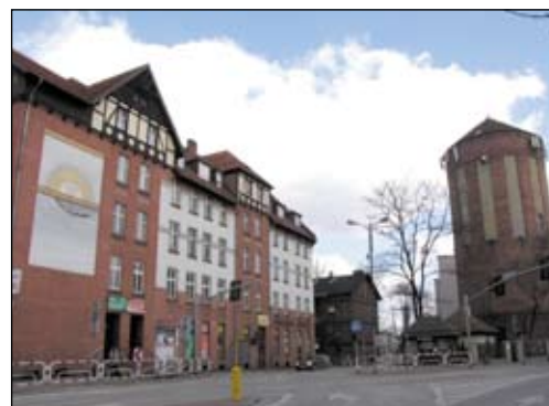
Dom i wieża ciśnieni przy ul. Chorzowskiej i Pokoju.
