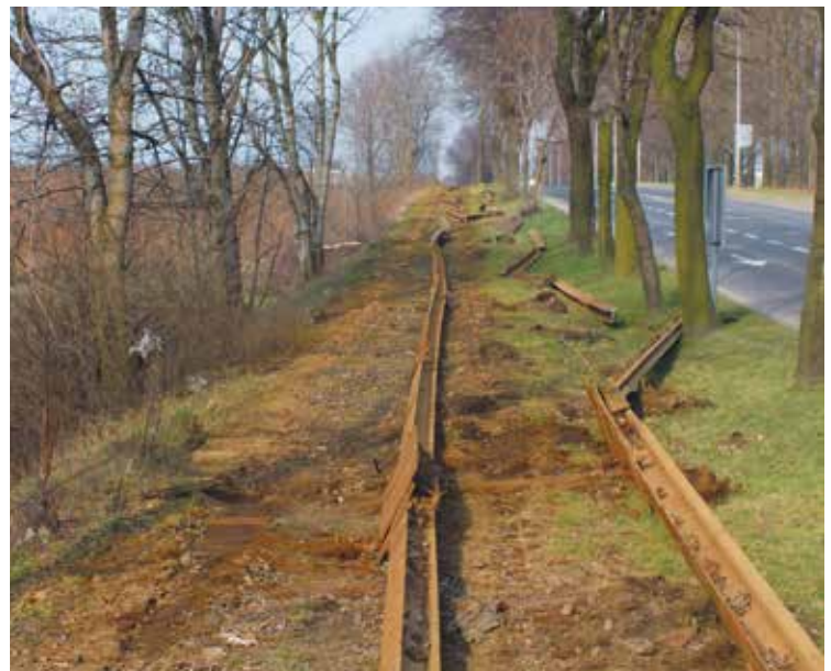
Torowisko wzdłuż ul. Zabrzeńskiej w Rudzie Śląskiej.
