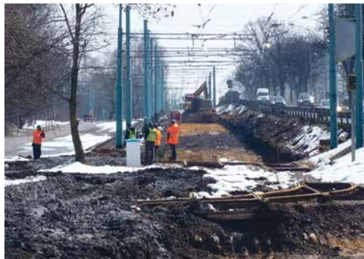
Torowisko w ul. Chorzowskiej w Katowicach.
