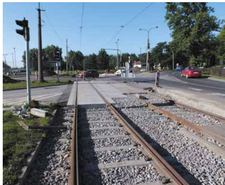
Ruda Śląska Chebzie Pętla przejazdu przy rondzie Unii Europejskiej.
