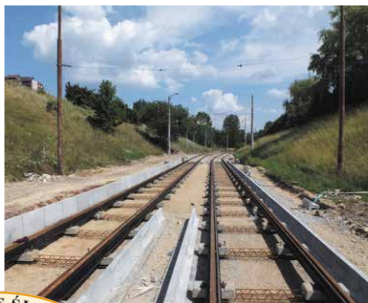
Sosnowiec ul. 3 Maja w rejonie pętli Zagórze.
