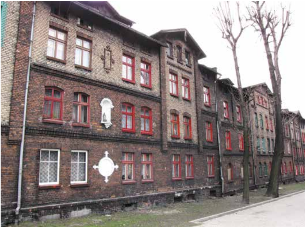
Domy przy ul. Podgórze.
