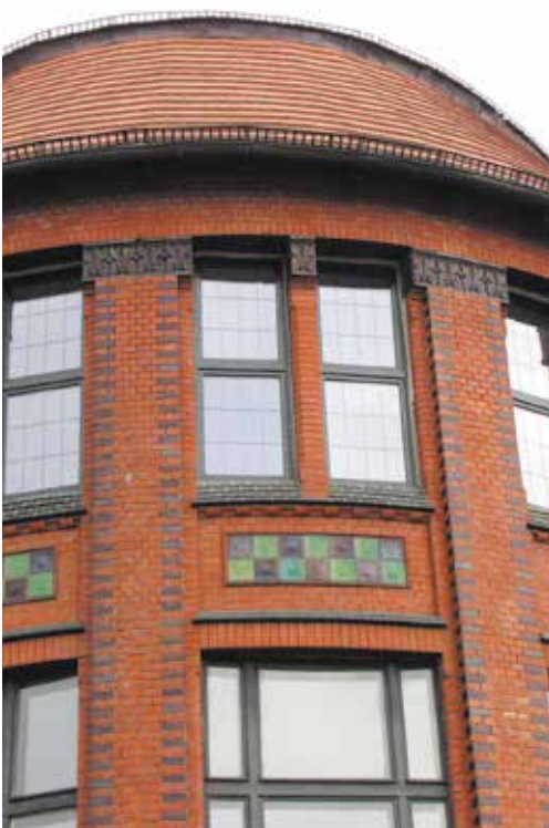
Fragment Kaufhausu przy ul. Niedurnego oraz dom przy ul. Gwardii Ludowej.
