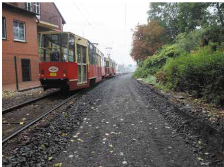
Odcinek między przystankami AKS a Chopina w Chorzowie.
