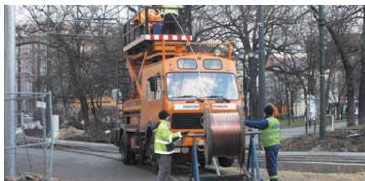
Montaż nowej sieci trakcyjnej na pl. Wolności w Katowicach.
