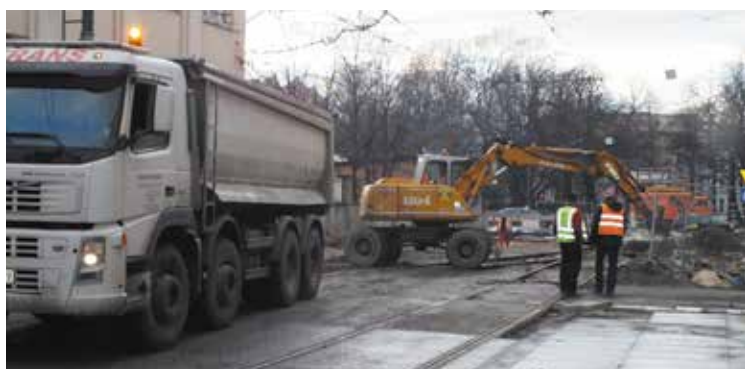
Początek prac na ul. 3 Maja w Katowicach.
