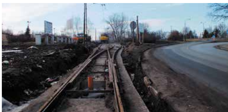
Modernizowane torowisko w Rudzie Śląskiej Chebziu.
