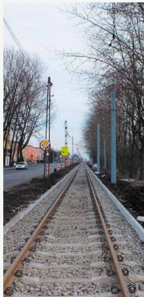
Gotowy fragment torowiska na ul. Zabrzeńskiej w Rudzie Śląskiej.
