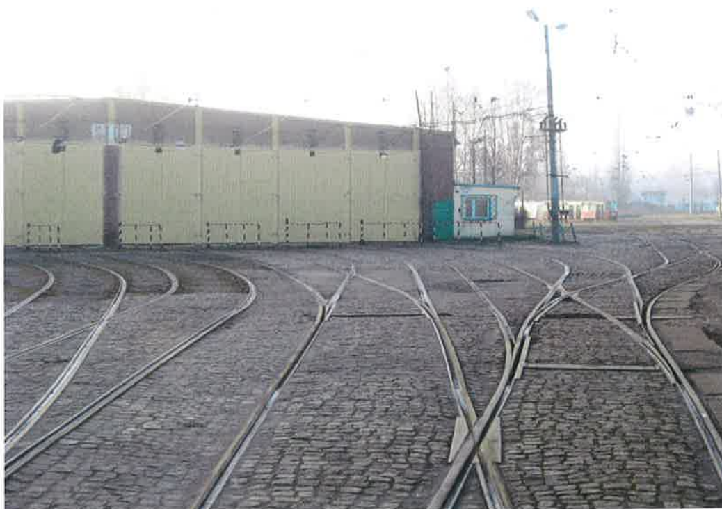
Zdjęcie nr.5 Odgałęzienie rozjazdami do hal i na pętlę tramwajową .
