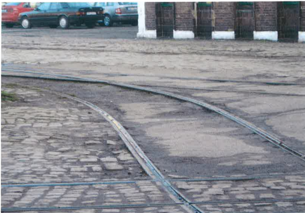
Zdjęcie nr. 7 Skrzyżowania torowe prze halą napraw i malarnią.
