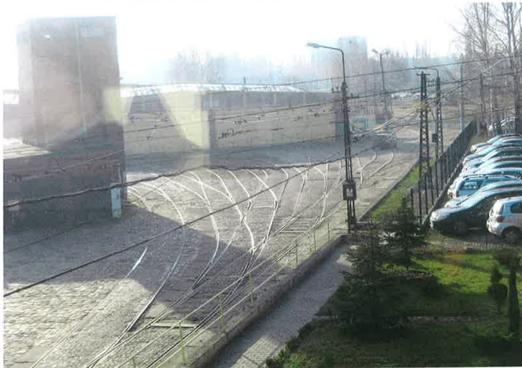
Zdjęcie nr 1 Głowica rozjazdowa - wjazd do hali napraw taboru tramwajowego oraz na pętlę tramwajową .
