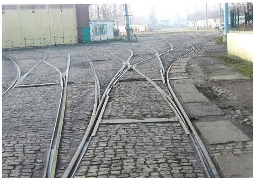
Zdjęcie nr. 6 Rozjazdy i plac zabudowany kostką granitową .
