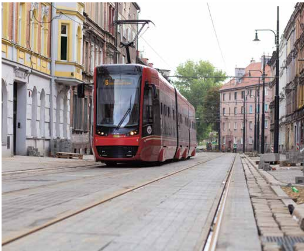
Bytom, ul. Katowicka
